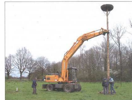
Het plaatsen van de nestpaal. ▲
